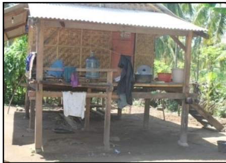
Kondisi 0% Atap : Seng Rapuh, Lantai : Bambu, Dinding : Gedeg Bambu
