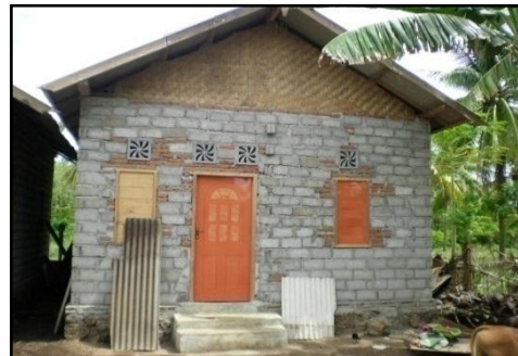
Kondisi 100% Atap : Seng, Lantai : Rabat beton, Dinding : Batako
